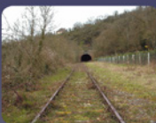
Entrée de tunnel ferroviaire
