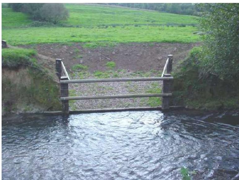
Les madriers ou diverses pièces de bois utilisés ne devront en aucun cas avoir fait l'objet de traitement chimique susceptible de dégrader la qualité de l'eau : trempages courts et longs, autoclave au cuivre-chrome-arsenic (autoclave au cuivre-chrome-bore autorisée). L'emploi de la traverse de chemin de fer est proscrit.
